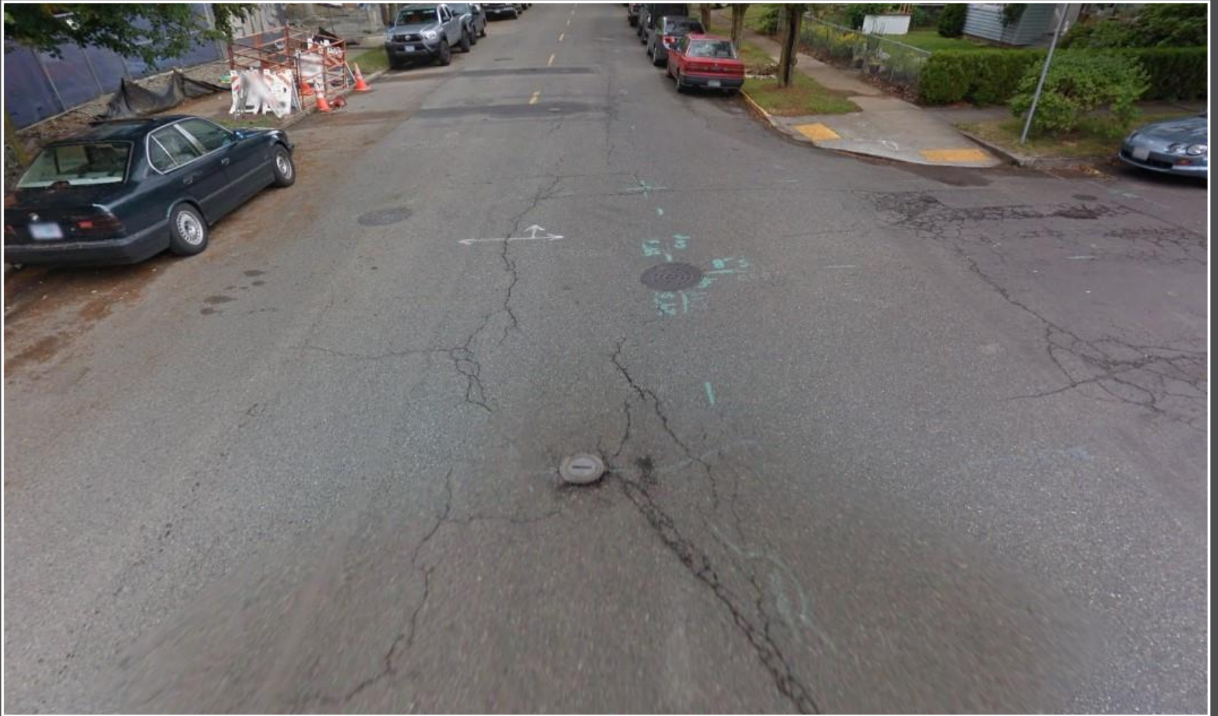
Microsurfacing – N. Ida (Before)
