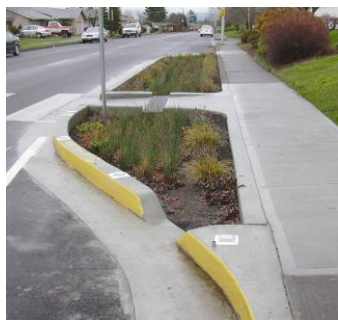
Curb Extension NE Fremont & 131 st Ave
